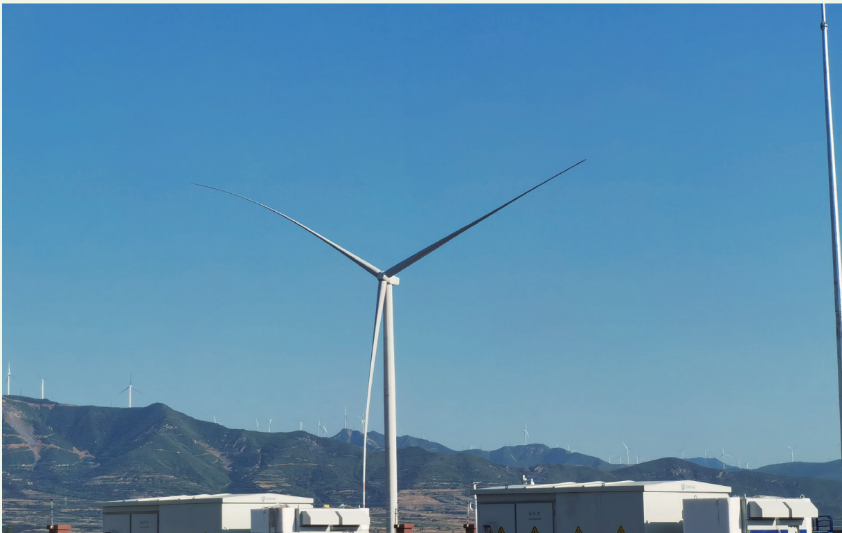
闻喜县200兆瓦风电直租项目
